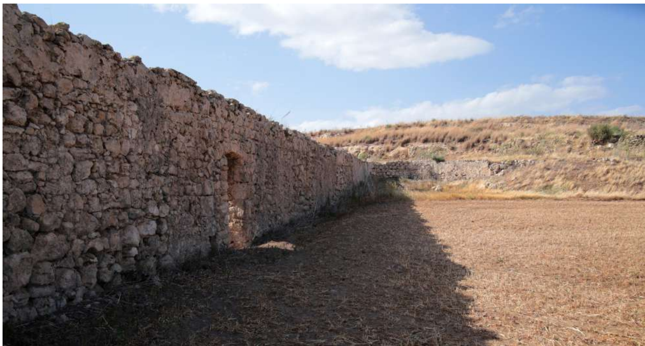
Contrada Sughero - Mulino Nuovo - condotto idrico sopraelevato (cavallo e saja) Foto Tony Vasile - Giugno 2016
