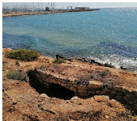
Fig. 40 - Marina di Ragusa – Trincea con ingresso a un bunker ricavato nella scogliera.
