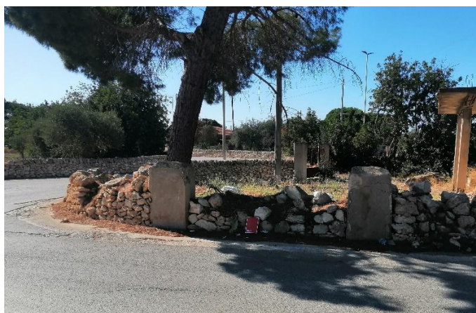
Fig. 46 - Inizio strada delle Vignazze - Manufatti in cemento, resti di un caposaldo, incassati nel muro.
