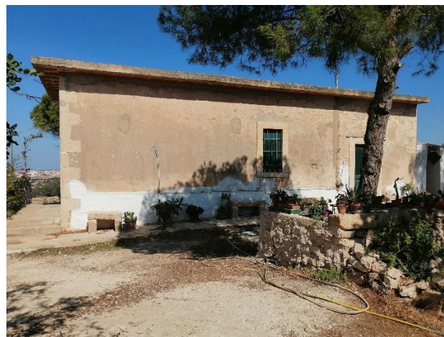
Fig. 44 - Cozzo Cappello – Case Farina, sede del Comando della 491 a Batteria Costiera.
