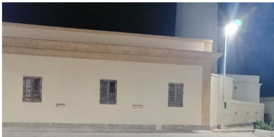
Fig. 51 – Punta Secca – Complesso di feritoie ricavate nei muri perimetrali dei fabbricati di servizio del faro, venute alla luce dopo un recente restauro.
